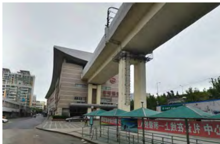
图4 轨道交通3号线赤峰路站公交枢纽 Fig.4 Bus terminal at Chifeng Rd. Station
