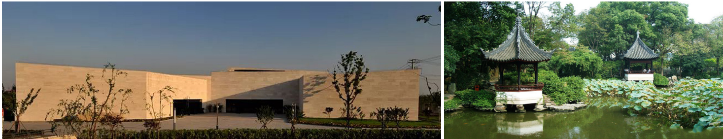
图2 既有新老特色建筑实景图 资料来源:笔者自摄。
