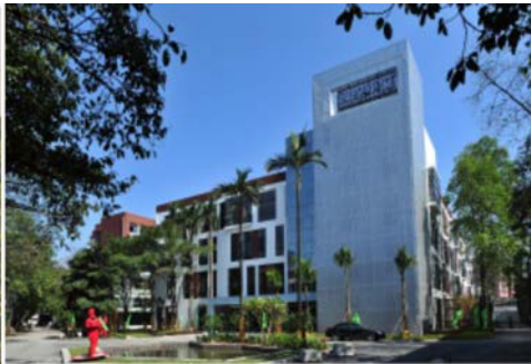
图4 一期园区内部改造前后对比 资料来源:根据相关资料整理。
