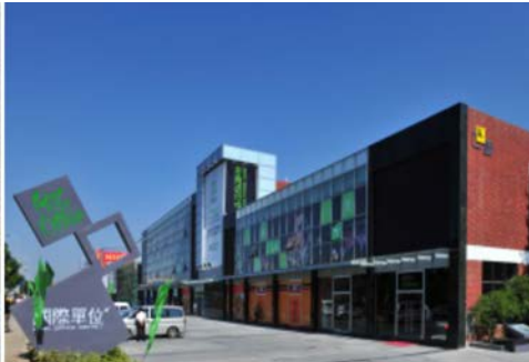
图3 一期园区入口改造前后对比 资料来源:根据相关资料整理。
