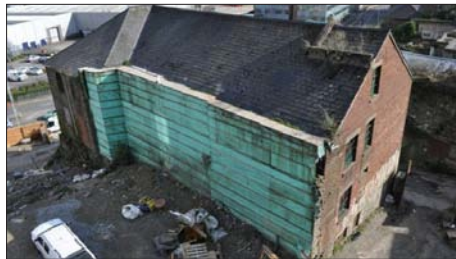
a) 改造前荒废的老场坊
