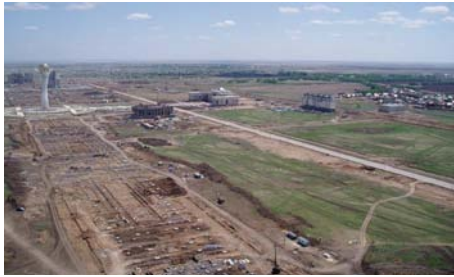
a) 正在建设中的南岸核心区域和标志性建筑
