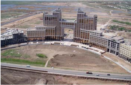
b) 正在建设中的南岸核心区域和标志性建筑
