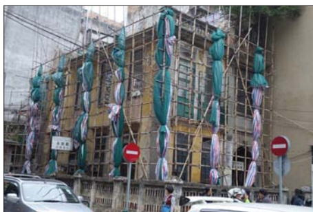
图14 经局部拆除后之亚利鸦架街28号房屋 (2016年1月)
