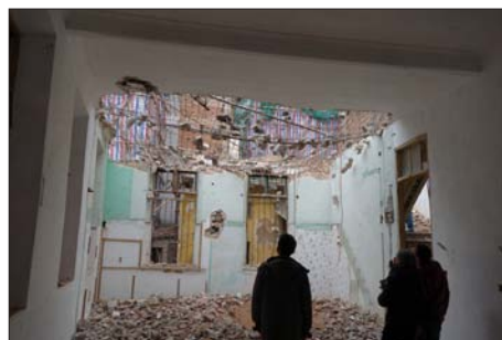
图15 经局部拆除后之亚利鸦架街28号房屋内部状况 (2014年2月)
