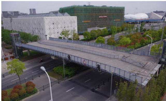
图2 人行天桥现状
