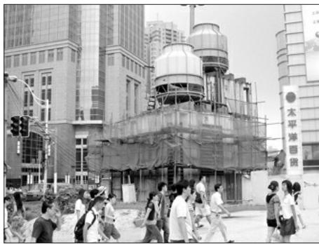
图16 地铁1号线徐家汇站原风亭与冷却塔资料图
