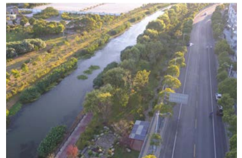
c 临港芦茂路海绵示范区
