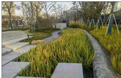
c 普陀区真如山姆购物中心上盖雨水花园
