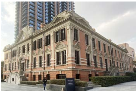
图11 总商会大楼现状修复后照片(2021年) Fig.11 Recent photo of SGCC after restoration (2021) 资料来源:笔者自摄。
