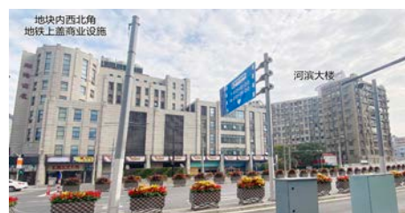
图8 河滨大楼地块内的地铁上盖商业设施(2021年)
