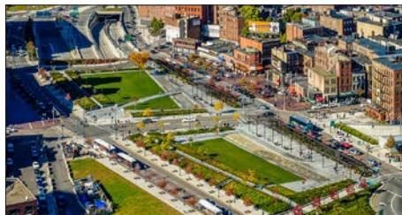
图6 波士顿“大开挖”项目建设实景
