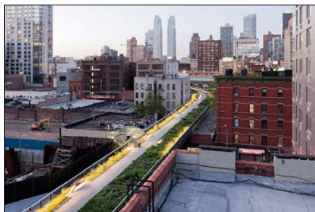
图5 纽约高线公园项目建设实景
