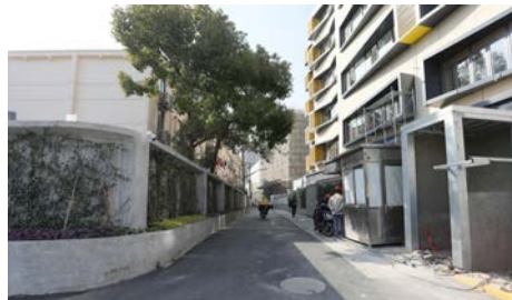
c 309弄入口空间改造实景图1
