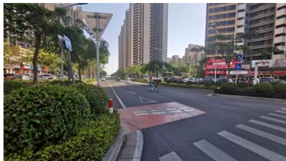
b 机动车停车线和斑马线之间的彩色涂装
