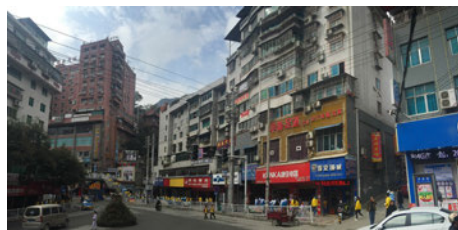
图10 铜遵路节点现状照片 (2015)
